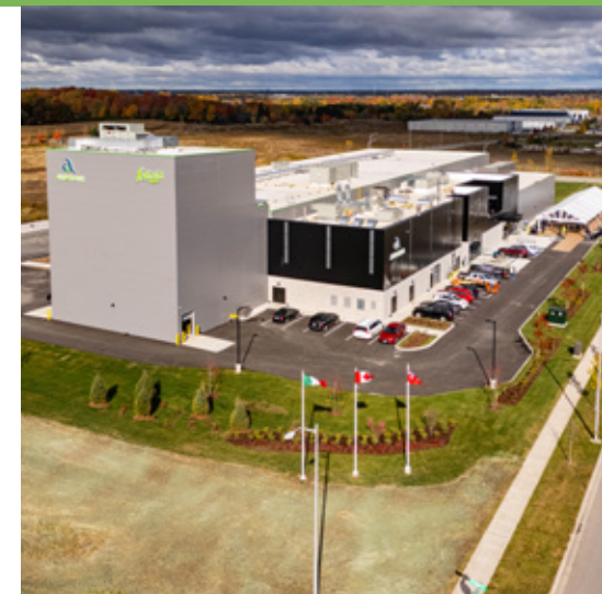
↑ Stabilimento di LONDON, CANADA
